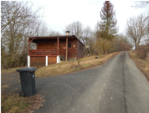
Blick von Süden auf Zufahrt mit Bestand
